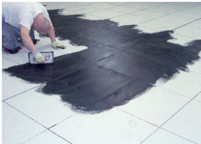
6 Fugázás Sopro Flexfuge FL-lel Sopro Electra Leitdispersion (ELD 458) elektromosan vezetőképes disperzió hozzáadásával.
