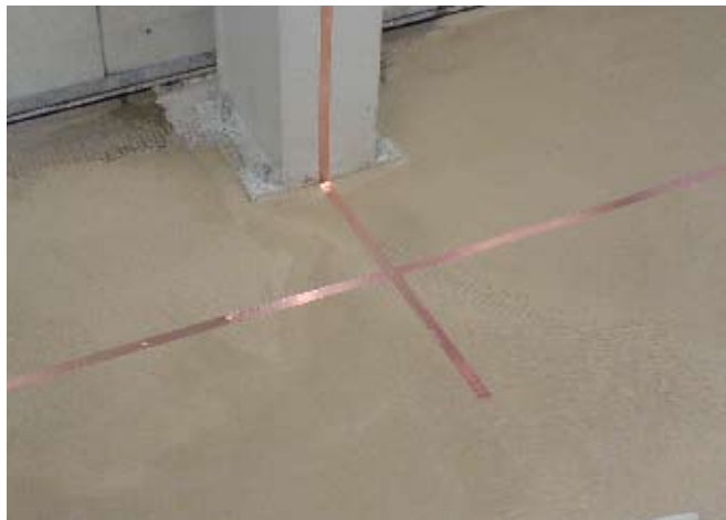
4 Rézhuza fektetése a következő rétegre a későbbi feszültségkiegyenlítés érdekében.
