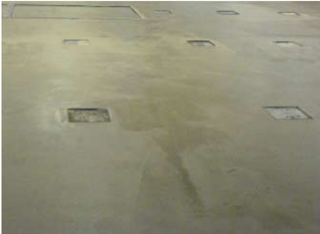
1 Sopro Fließspachtel FS 15 plus-szal kiegyenlített aljzat, lealapozva a következő rétegekhez.
