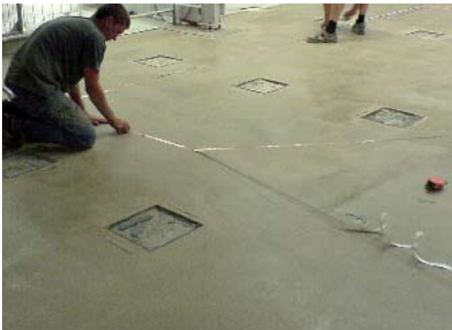
3 A rézhuza felragasztása a megfelelő rácsszerkezetben.
